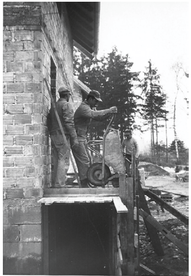
Pouring the Porch.
